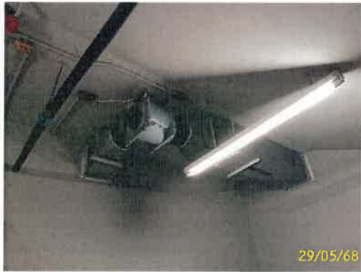
ระบบระบายอากาศห้องสารเคมี
