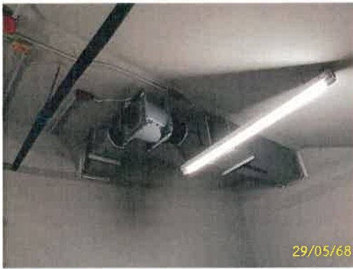
ระบบระบายอากาศห้องสารเคมี
