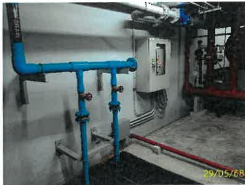
บ่อรับน้ำฝน และตู้ควบคุมชั้นใต้ดิน
