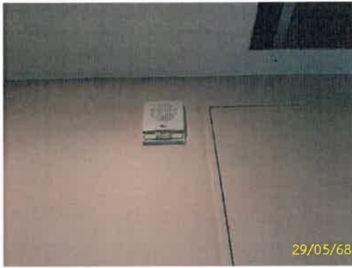
อุปกรณ์แจ้งเหตุเพลิงไหม้ด้วยเสียง และแสงไฟ
