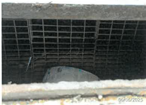
ตะแกรงบ่อบำบัดน้ำก่อนปล่อยน้ำออกนอกโครงการ
